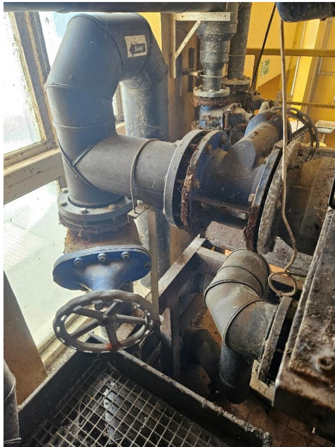
Fot. 2 Armatura i rurociąg w budynku mechanicznego oczyszczania ścieków (w okolicy przepięcia ścieków)
