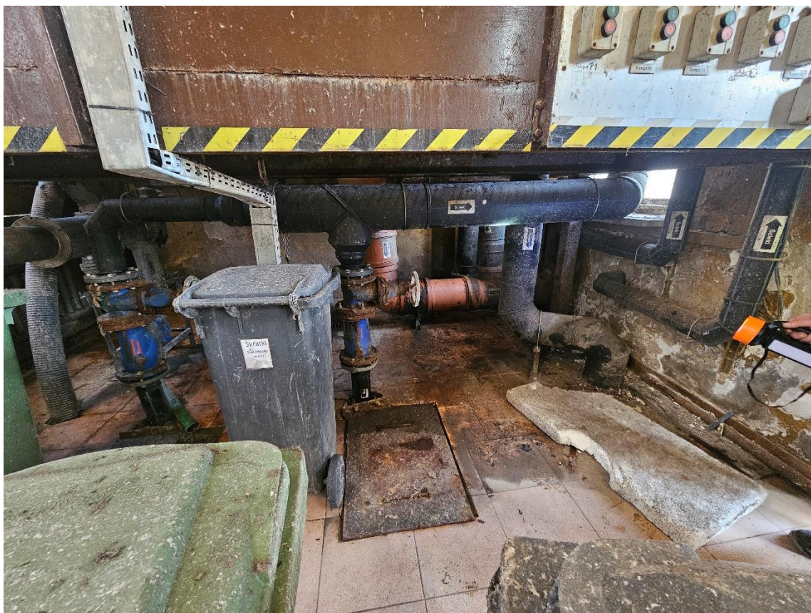
Fot. 4 Rurociągi wraz z armaturą z pompowni I stopnia (miejsce montażu „bypassu”)
