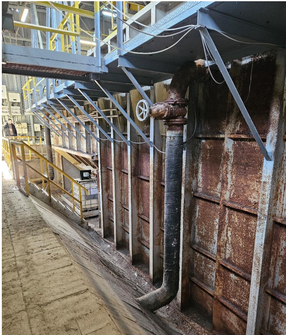
Fot. 7 Zbiornik istniejącej komory tlenowej stabilizacji osadu (w głębi) oraz komory denitryfikacji wraz z rurociągiem tłocznym doprowadzającym ścieki surowe i zasuwą
